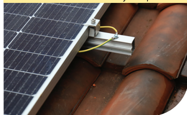
Slika 8: Noseća konstrukcija za panele
