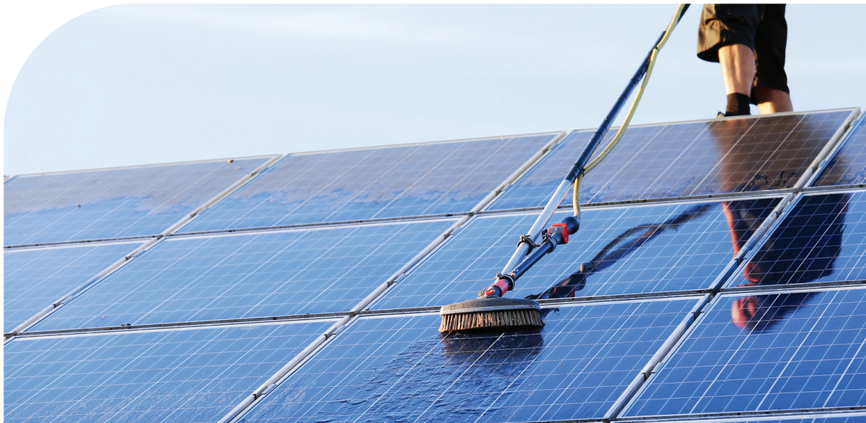
Slika 13: Čišćenje fotonaponskih panela
